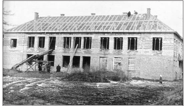
Historický záber z výstavby budovy Základnej školy vo Vlachove. Foto: archív ZŠ
